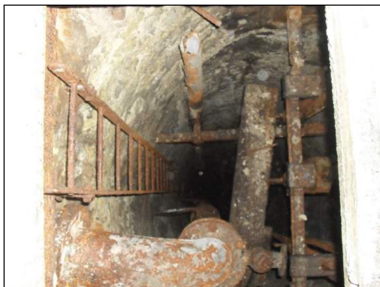
Photographie 3 : aperçu de l'intérieur du forage 03284X0002/F
