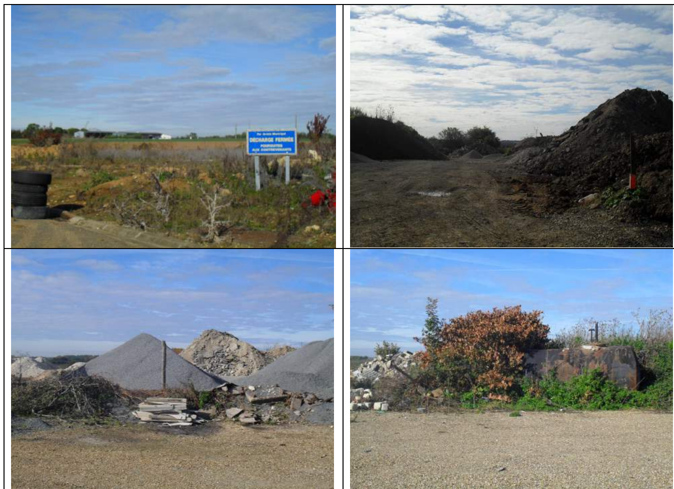
Photographie 4 : Aperçu de la zone de dépôt
