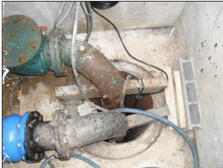
Photographie 2 : Vue sur la tête du captage
